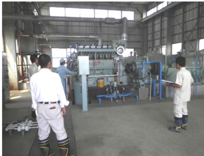
深谷市によるポンプの点検状況
