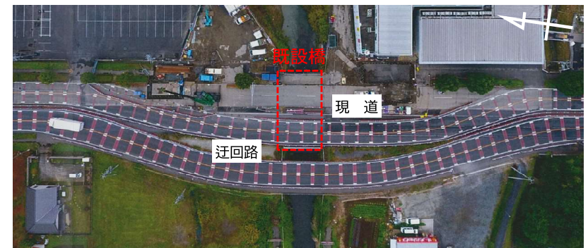
橋りょう架換え工事 一般国道407号（片柳二号橋）
