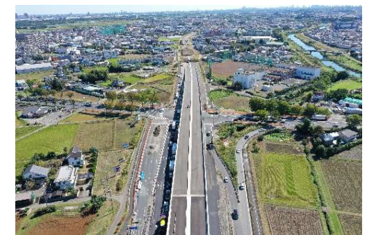
整備状況 国道254号（和光富士見バイパス）
