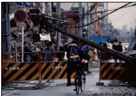
阪神淡路大震災による電柱倒壊
