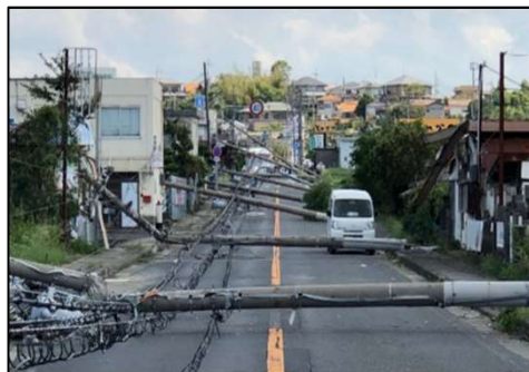
平成30年台風第21号による電柱倒壊
