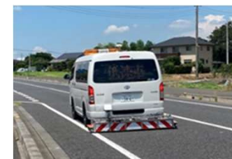
路面下空洞調査の状況
