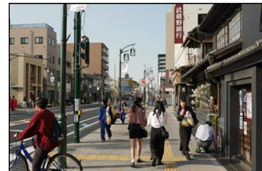
無電柱化の整備箇所 (都) 中央通り線 (川越市)
