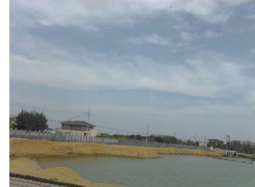
現在行われている掘削状況
