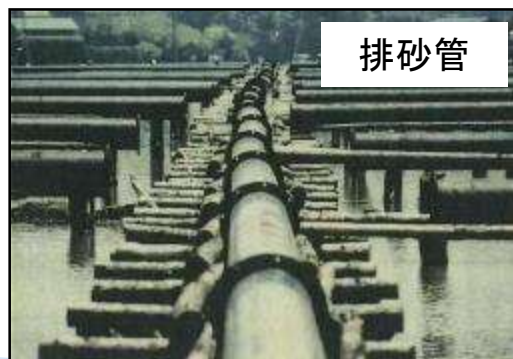
排砂管により権現堂川から砂を運ぶ様子
