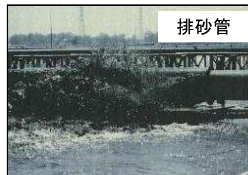
排砂管により権現堂川から砂を運ぶ様子
