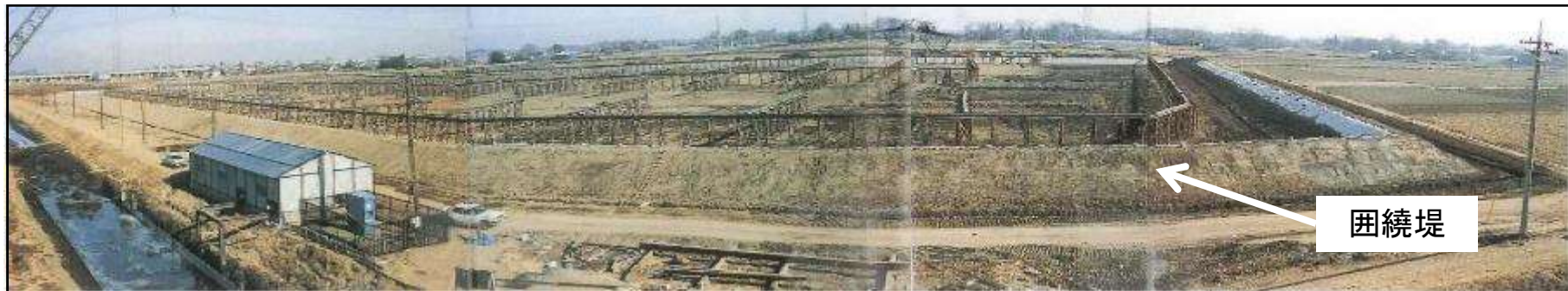
囲繞堤内全景
