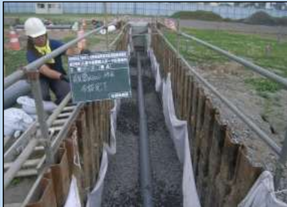
排水溝施工の様子
