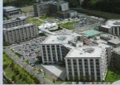
病院の屋上ヘリポート確認
