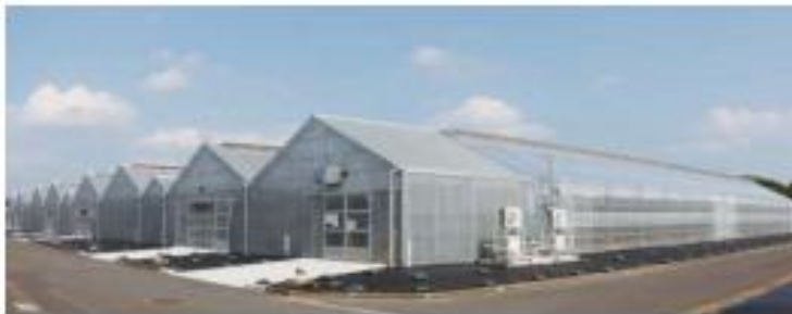
最新の環境制御・かん水設備のいちご高産増殖ハウス（2019.3月竣工）
