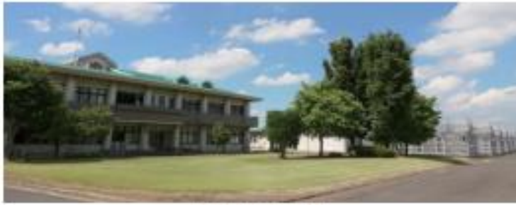
管理研修棟・ガラス温室
