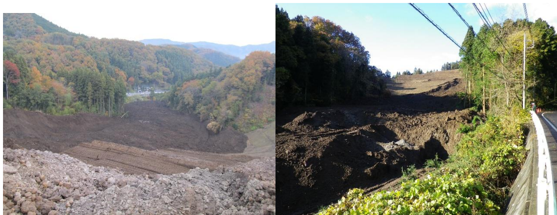
盛土崩落事故直後の写真
