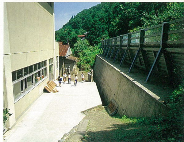
小学校を守る落石防止柵。子供たちは安心して勉強にスポーツに励むことができます。坂本 昭和52年度 東秩父村坂本
