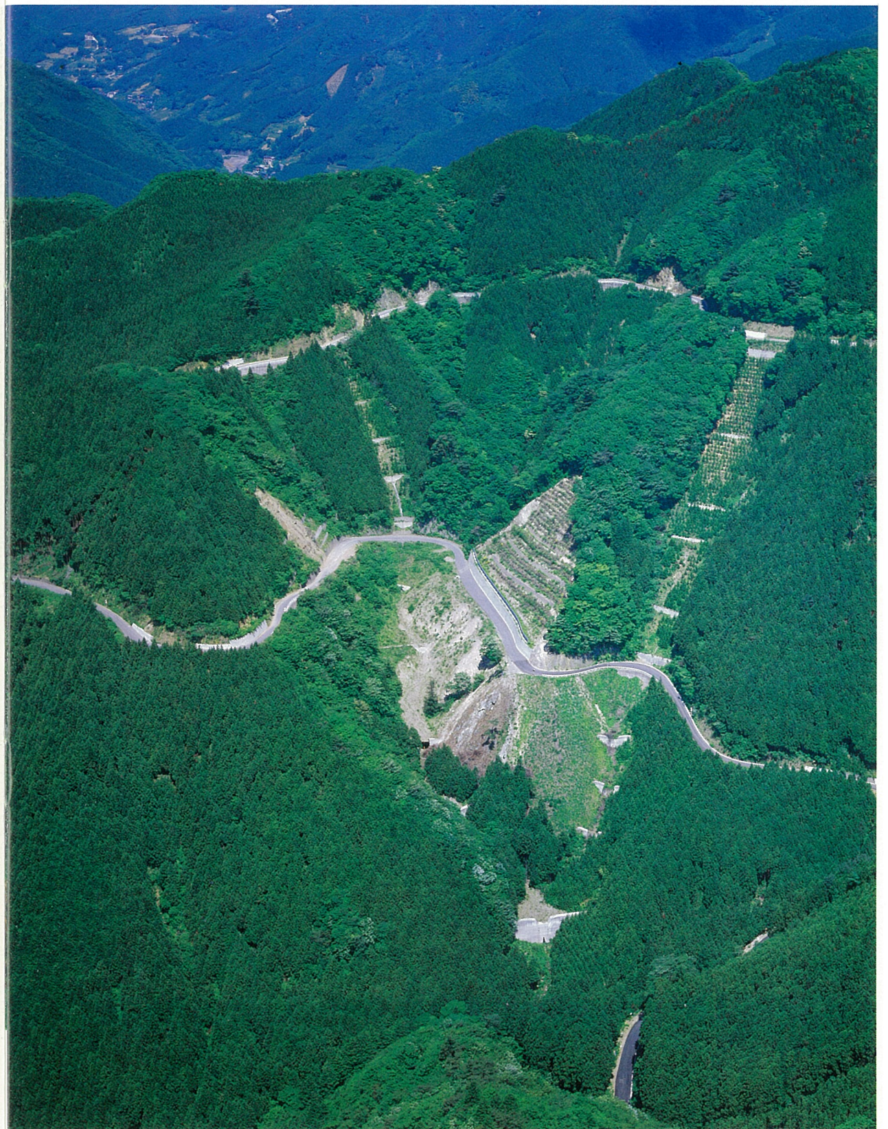
森林を復旧し、通行する人びとを災害から守る山腹工事。空から見ると復旧の様子がよくわかります。苅場坂 昭和43～51年度 飯能市北川
