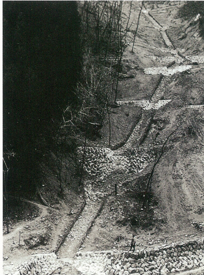
水源荒廃林地復旧事業 昭和14年(吉田町)
