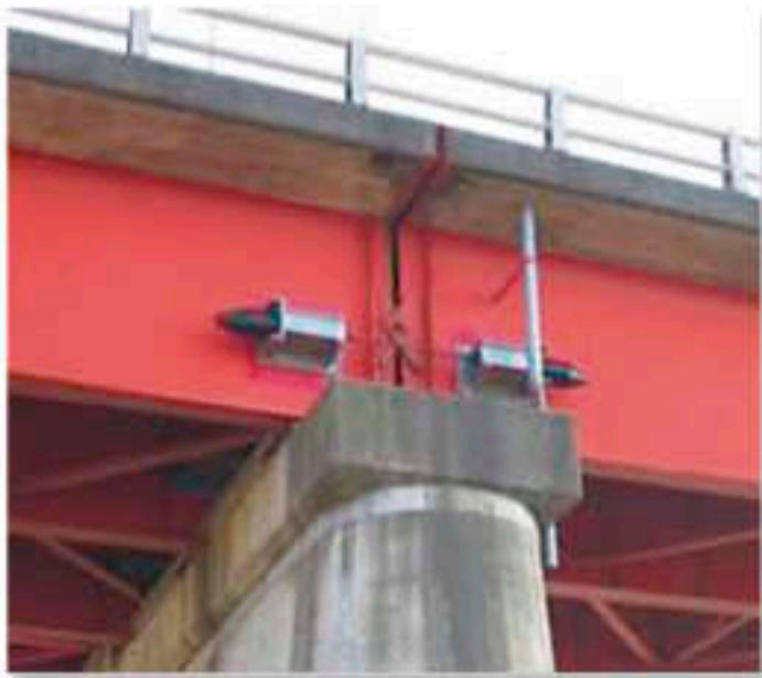
横りょうの耐震補強(落下防止)
