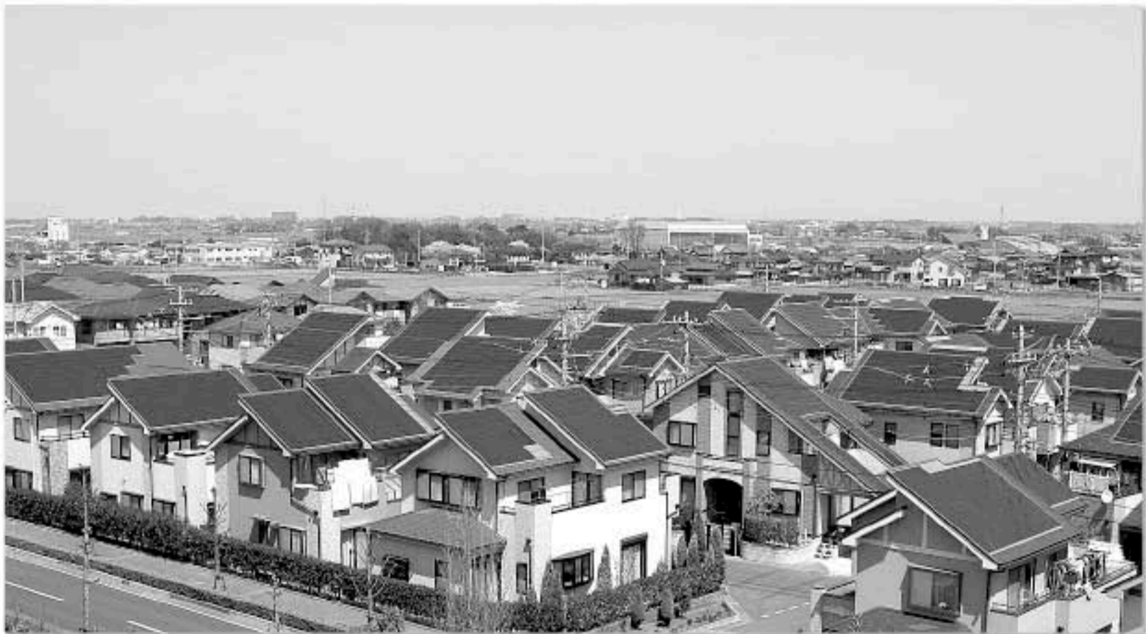
太陽光発電設備が設置された住宅群(吉川市)
