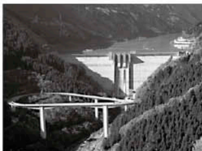
滝沢ダム(秩父市)
