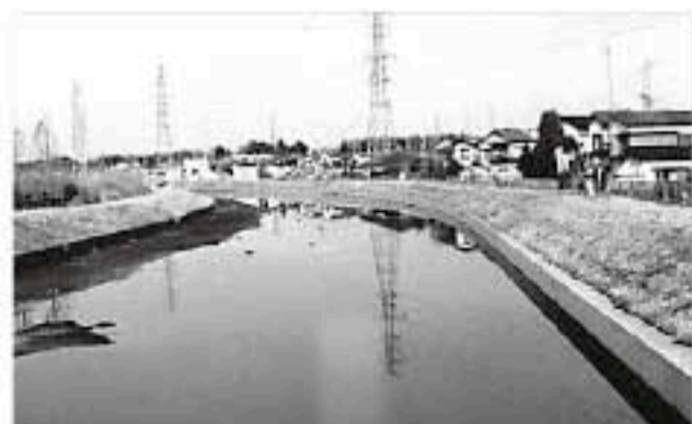
河川改修により川幅を広げた一級河川鴨川 (さいたま市)
