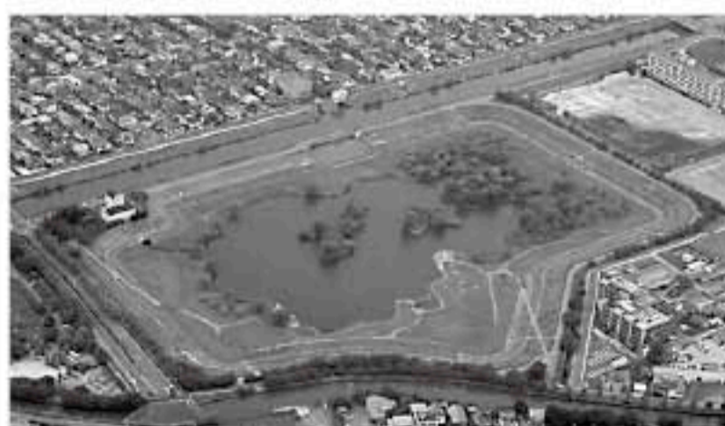
一級河川新方川に整備した大吉調節池(越谷市)
