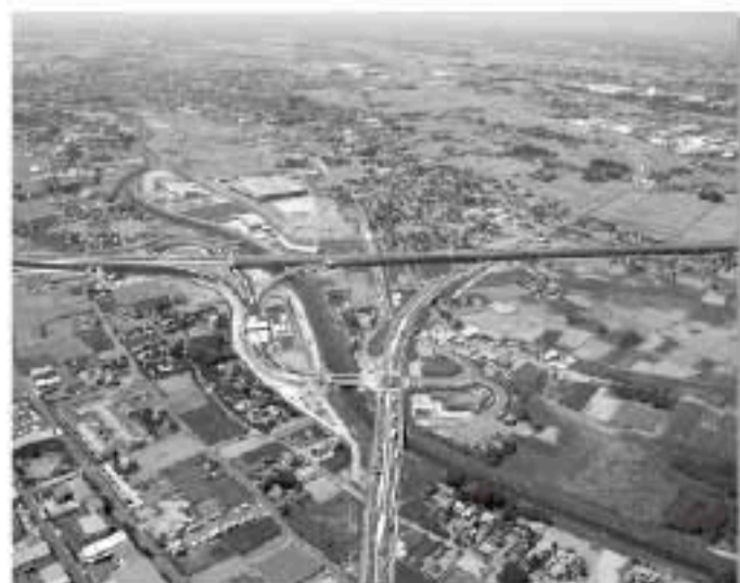
圏央道白岡葛尾インターチェンジ（久喜市・白岡町）
