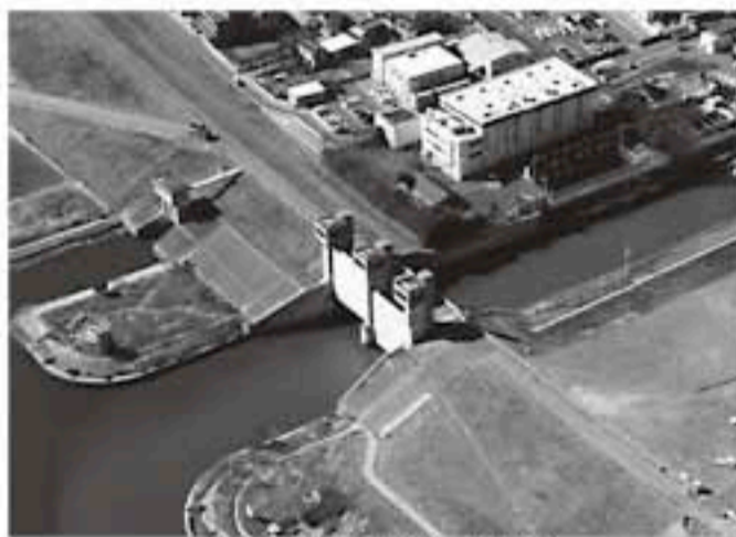
笹目川排水機場(戸田市)
