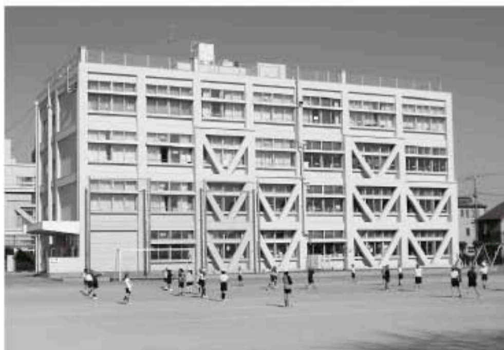
耐震補強後の校舎(入間市立藤沢小学校)
