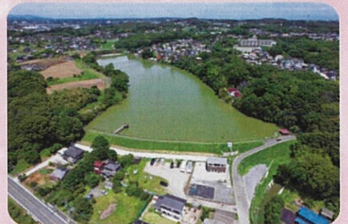
農地防災事業(ため池等整備) 大沼(大)地区
