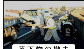
落下物の撤去
