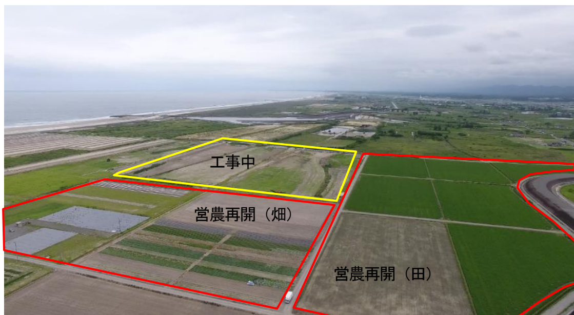
H27 年度完成の農地と現在工事中の農地
