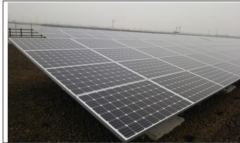
岩沼市藤曾根地区太陽光パネル
