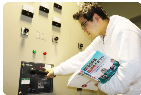
電気受電設備実習
