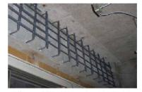
配筋し、この後型枠を組立てコンクリートを打設します。 鉄筋材の擦れ合う音が発生しますが、騒音発生は少なめ です。(開庁日作業) 型枠組み立て・コンクリート打設では騒音・振動が多少 発生します。基本的には開庁日作業です。
