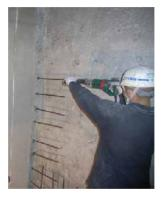
アンカー鉄筋を打設します。 サイレント工法ですので、 使用しながら工事に対応した 工法ですが、機械のモーター 音や打込みの際、若干の 振動が出ます。 (開庁日作業) 閉庁日に集中して行う場合 もあります。
