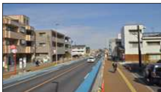
無電柱化の実施状況（保谷志木線）
