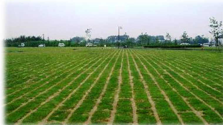
浄水発生土を利用して整備したグラウンド
