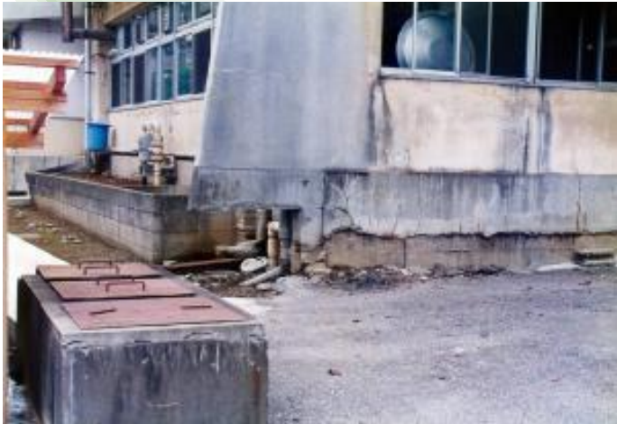
地盤沈下により抜け上がった建物の基礎 (出典：埼玉県HP)
