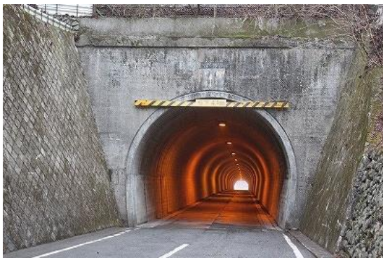
国道 299 号、志賀坂トンネル
