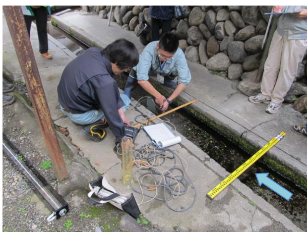
電磁流量計にて水量測定を行った
