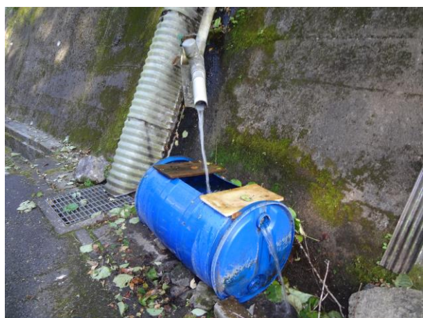
湧水は、ドラム缶を通過して道路側溝を流れた後、赤平川に流入する
