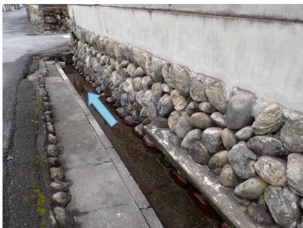
湧出した水は、20m程度道路に接する形で流れた後、暗渠に流れる
