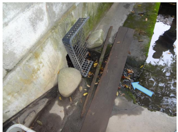
湧出した水は池を通過した後、道路側溝を 流れて直接荒川に流入すると推定される
