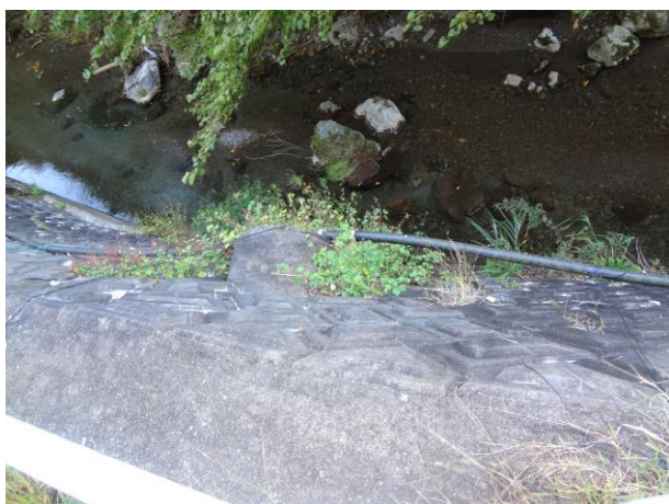
湧水は暗渠により道路を横断し、吉田川に流入する
