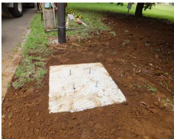
・工場で製造・養生しますので、強度が確実に発現し、天候にも左右されません。
