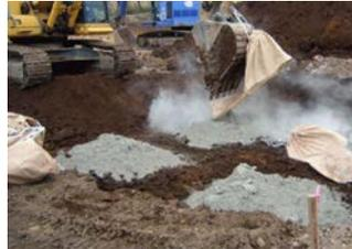
表層改良工事の場合固化材と土壌を攪拌と同時に還元剤（液体）を散布する。工法を変えることなく安全に施工が可能。
