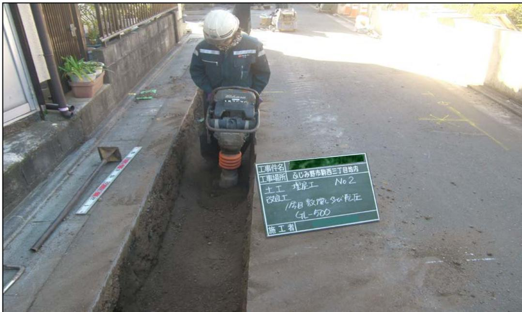
再資源化された改良土（製品名：ユニ・ソイル）は、第2種改良土以上の強度（品質）が確保でき、また埼玉県土木材料規格の品質を満足した埋め戻し材としてリサイクルされます。
