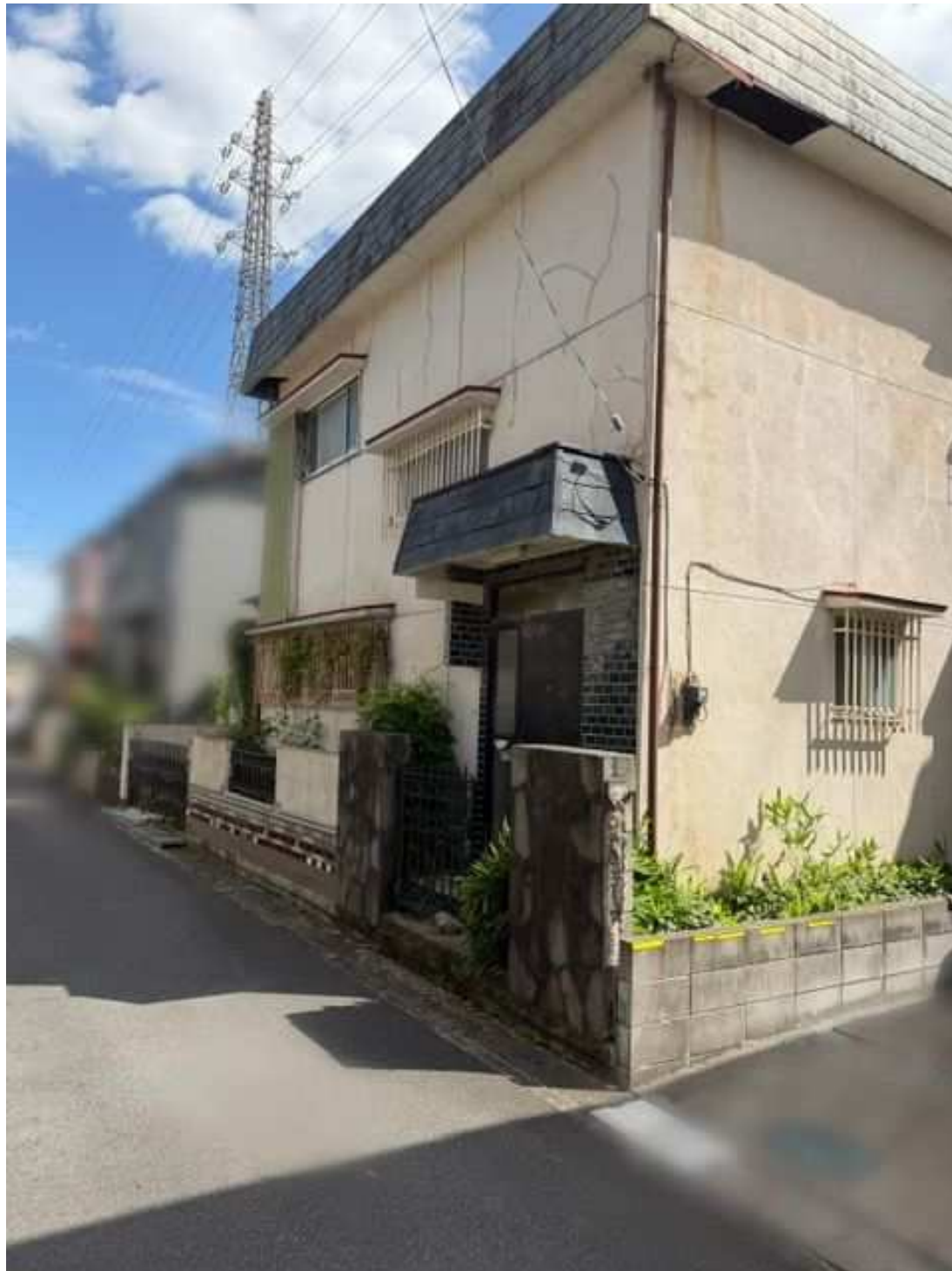
〔写真①〕 建物 西から
