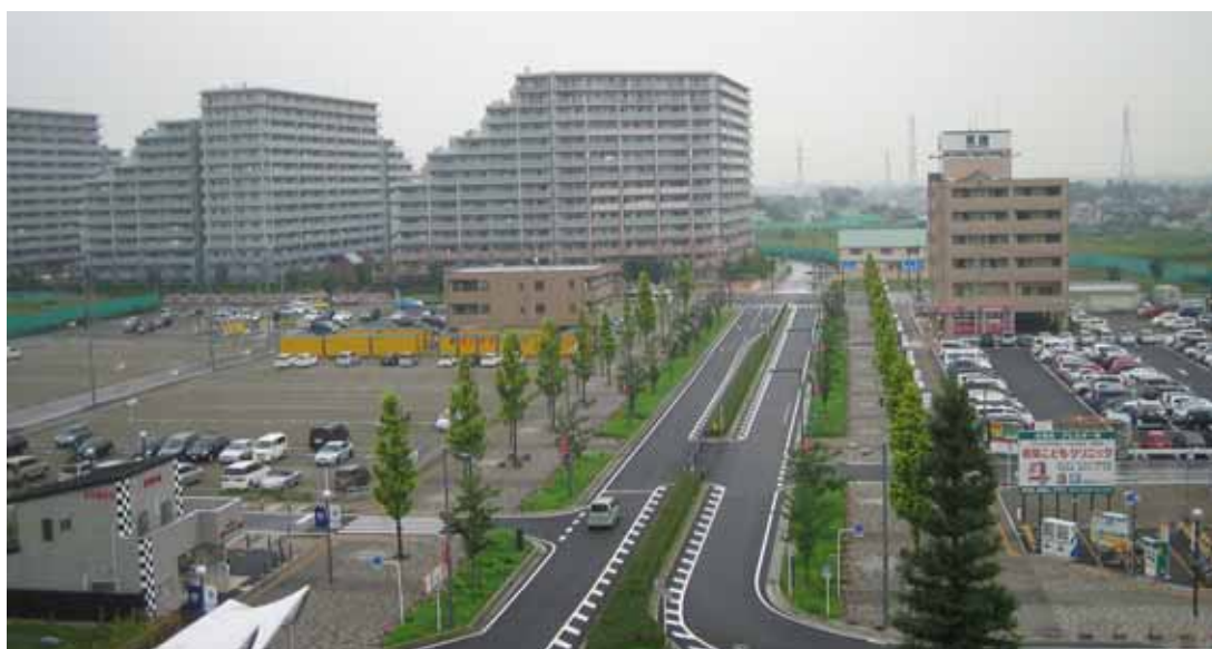
写真 浦和美園駅東口周辺の開発状況
