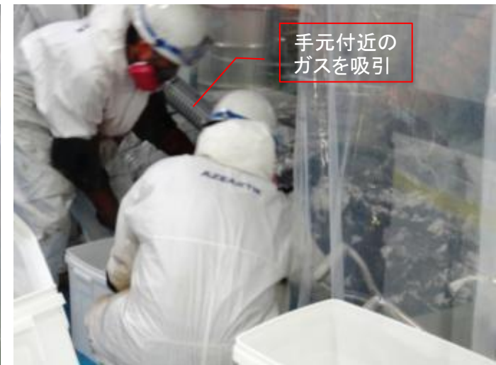
⑥ 密閉容器に詰め込み (シート被覆、手元付近のガスを吸引)
