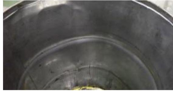
内壁の清掃後
