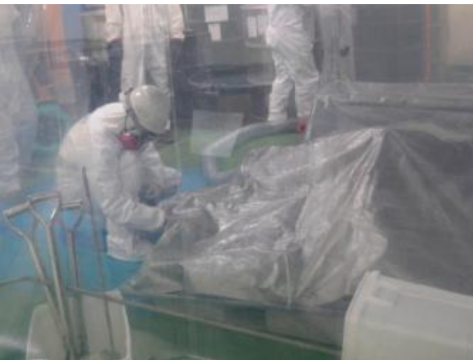
④ シート内部のガス測定
