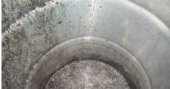
内壁の清掃前
