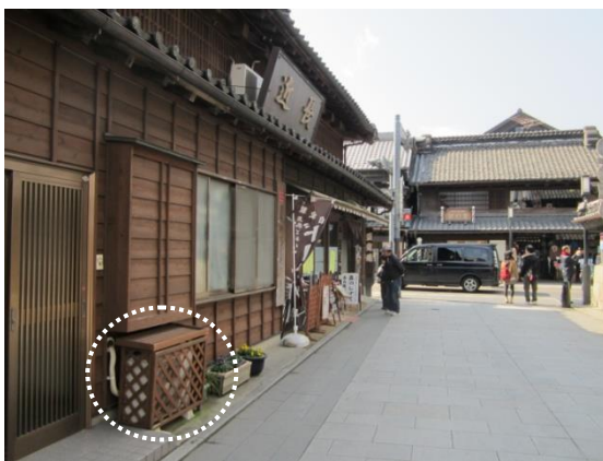
空調室外機を道路側から見えないようにしている。
