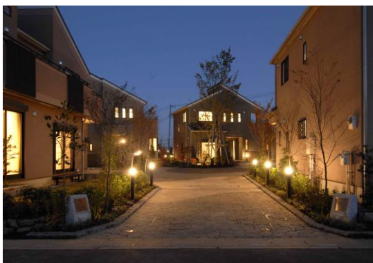
景観と防犯に配慮して道路・広場に 屋外照明を設置
