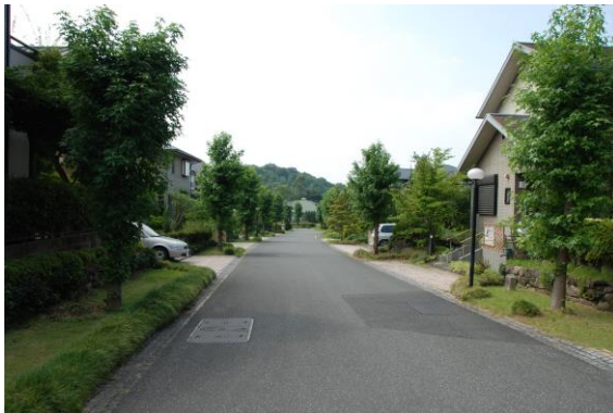
電線を地中化し、景観阻害物を排除。 土留めの高さを低くしている。
