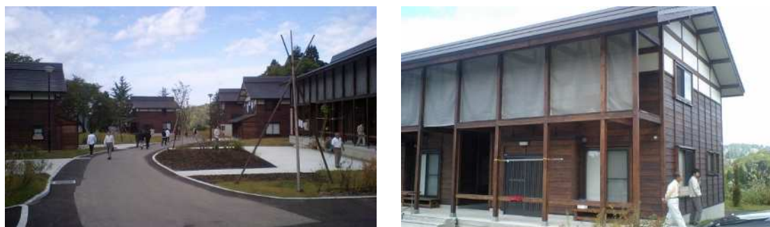
図 1.1.2-4 竹沢地区公営住宅の様子
