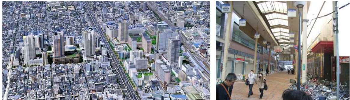
図 1.1.2-1 新長田地区の市街地再開発事業(左:俯瞰図、右:現況写真)
