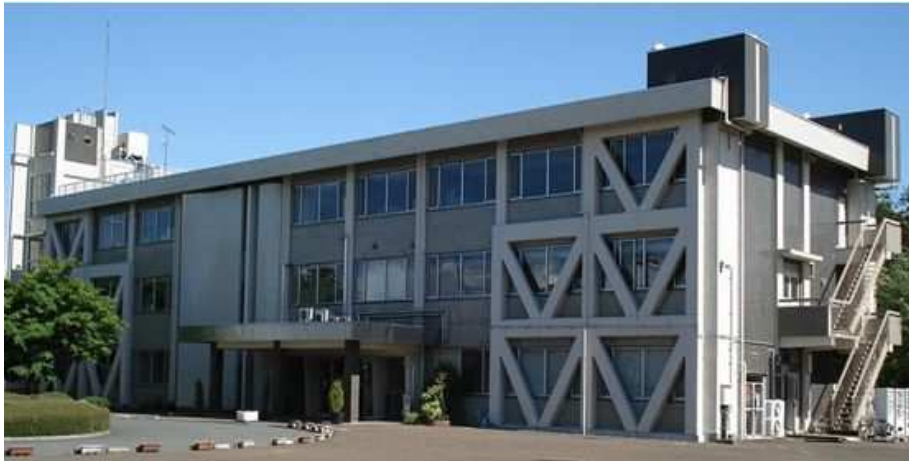
農業技術研究センター本所（本館）
