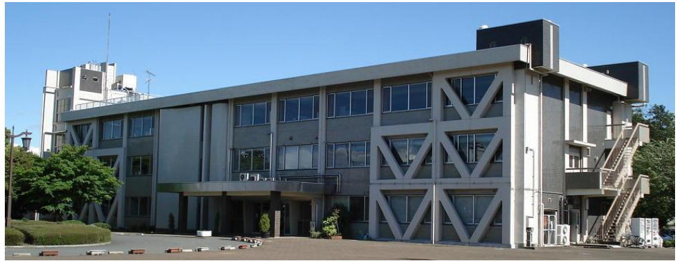
本所 本館全景
