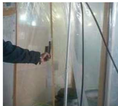
図 4-12 セキュリティゾーンの入口の気流方向の確認（参考：出典 1 P225）
