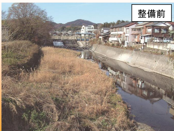
水辺へのアプローチがない(H21.10撮影)
