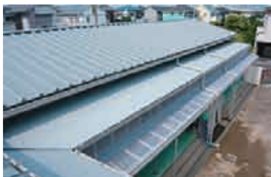
図8.4 銀座保育所屋根の施工場所
