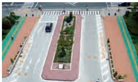
図8.3 熊谷市役所前の施工場所
