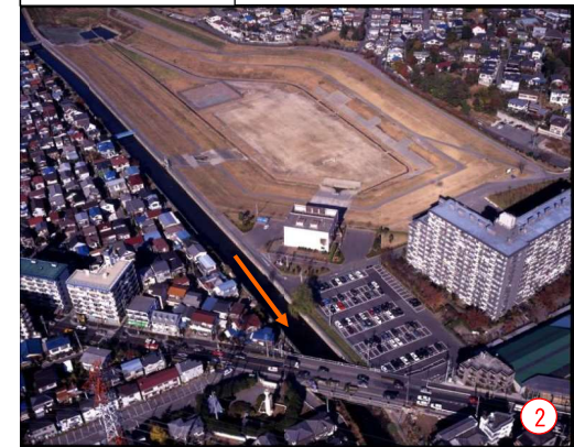
上谷沼調節池
