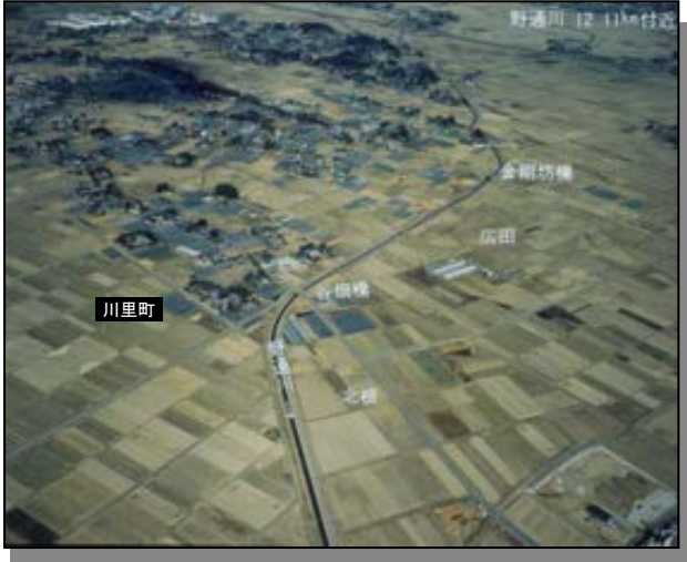
②野通川11km付近
