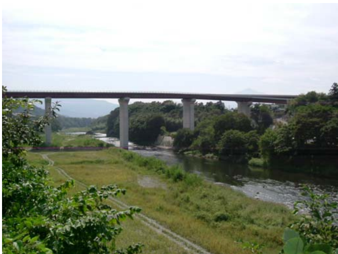
新皆野橋整備状況①
