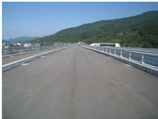
新皆野橋整備状況②
