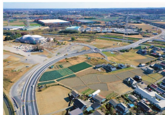
主要地方道 花園本庄線バイパス(深谷市～本庄市)
