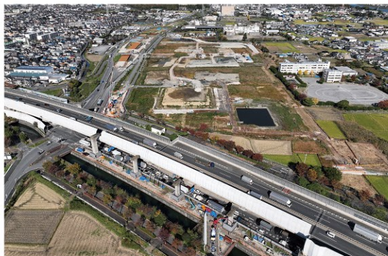
東京外環自動車道 (仮称)外環八潮PA付近(八潮市)
