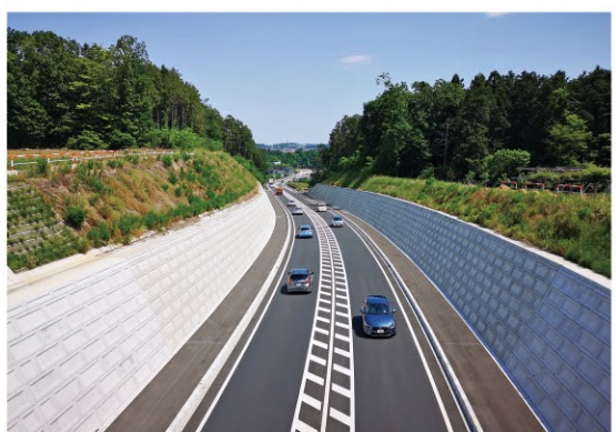
主要地方道 飯能寄居線 新堀北平沢工区(日高市)
