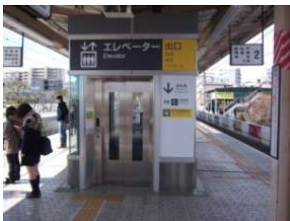
エレベーター
