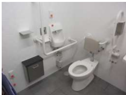
障害者対応型トイレ
