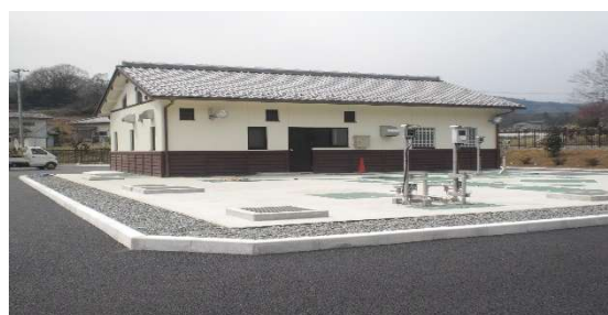
農業集落排水処理施設
