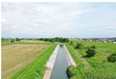
整備された用水路
