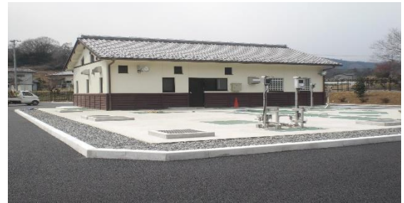
集落排水処理施設
