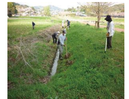
水路の泥上げ作業
