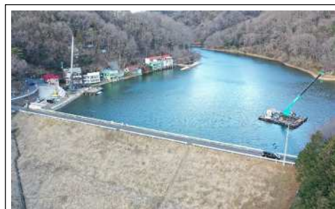
農業用ため池の耐震工事（円良田湖）
