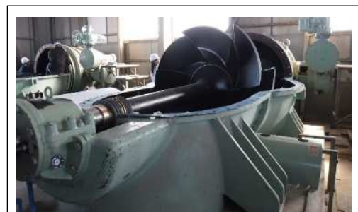
排水機場の修繕工事の様子
