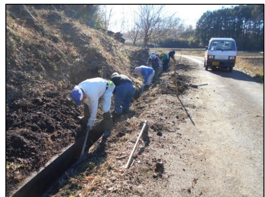
地域ぐるみでの共同作業(水路の泥上げ)
