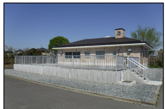
整備された農業集落排水処理施設
