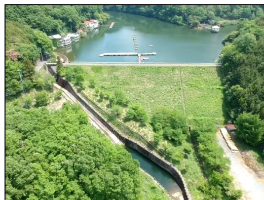
耐震工事が進むため池 (円良田湖)
