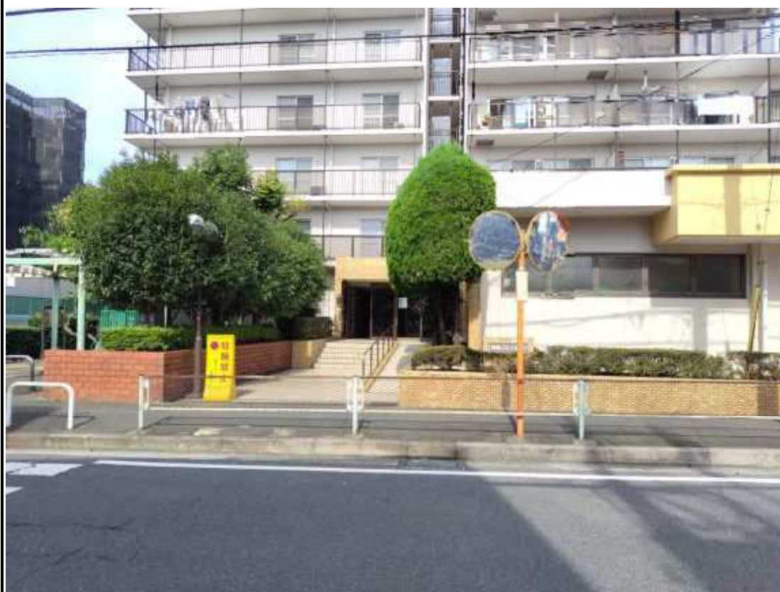
【写真③】 建物入口
