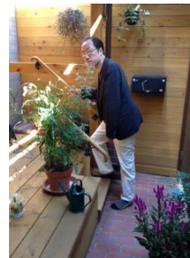
テラスの階段 リニューアル工事
