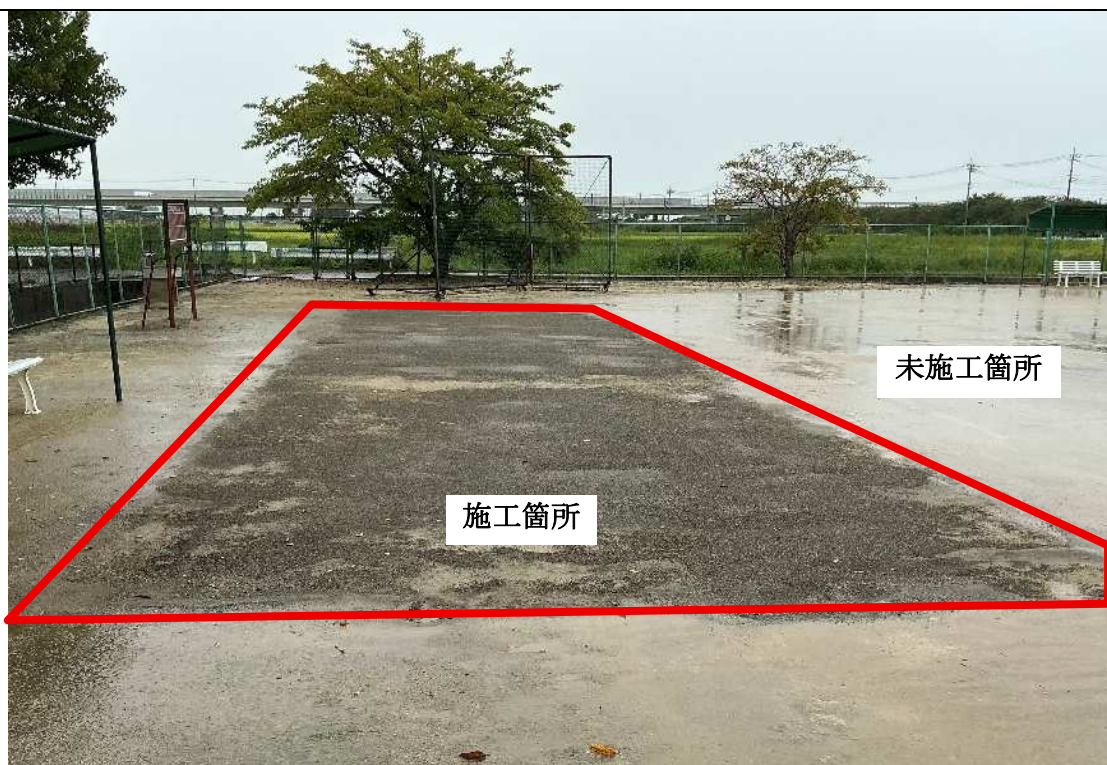
施工箇所・未施工箇所①（9月11日13時頃）
