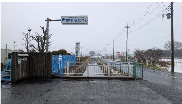
図1 埼玉県春日部中継ポンプ場(上)と下水が排水された水路(下) (2025年3月5日撮影)
