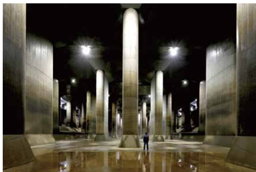
首都圏外郭放水路／写真提供：国土交通省 関東地方整備局 江戸川河川事務所
