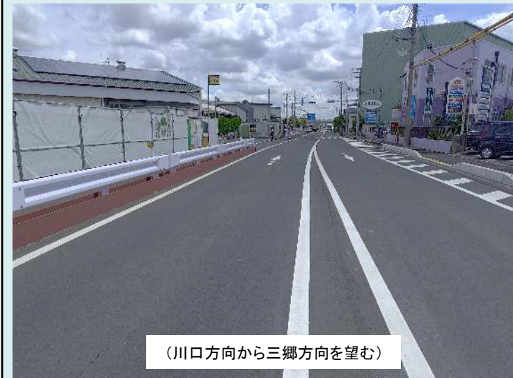
県道松戸草加線 2車線での供用
